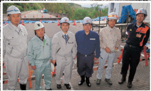
権兵衛峠道路崩落現場の視察
