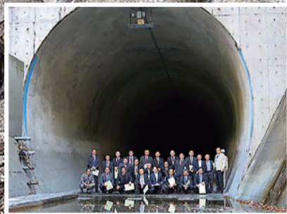
小浜排砂トンネル
