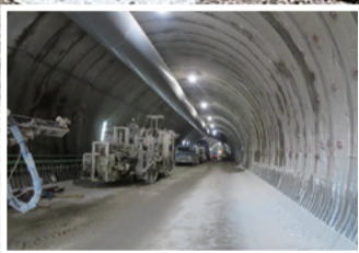
粒良脇トンネル
